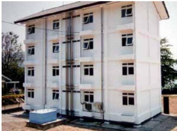
**Figura 3.12:** Edificación en Java, Indonesia, construida con el plano de aislamiento sobre el terreno. (Fuente: Kelly, J. 2013).
