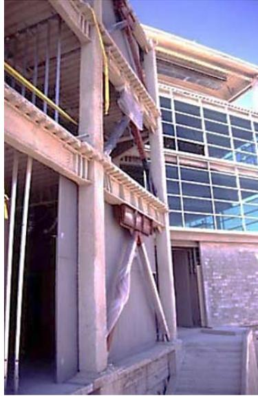
**Figura 8.6:** Edificio corporativo de 3M, diseñado con dispositivos viscoelásticos. (Fuente: Tena-Colunga, 2003).<sup>36</sup>
