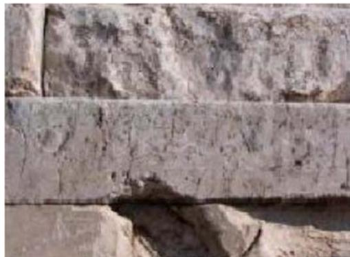
**Figura 1.5:** Capas de piedra cortadas y sin mortero para permitir deslizamiento en tumba de Ciro. (Fuente: Bayraktar, A. et al., 2012).
