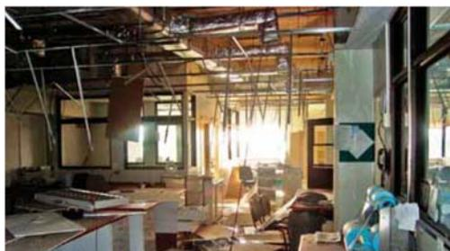
**Figura 2.1:** Hospital que presentó daños no estructurales que impidieron su funcionamiento inmediato, luego del terremoto de Chile de 2010. (Fuente: EERI, 2010).
