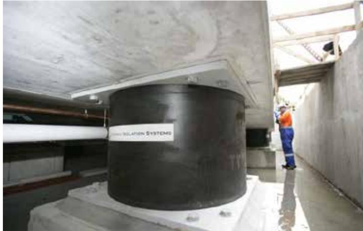
**Figura 3.13:** Espacio para el movimiento libre de los aisladores y acceso para revisión.<sup>25</sup>
