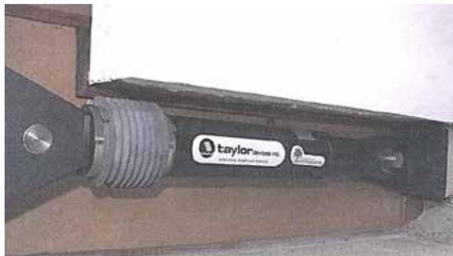
**Figura 8.17:** Tipo de amortiguador viscoso utilizado y estructura de soporte, llamadas “paletas estructurales”. (Fuente: Morón A., 2009).
