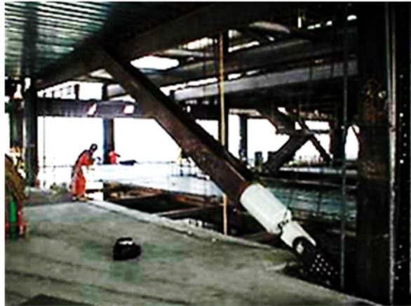
**Figura 8.10:** Disipadores instalados en la Torre Mayor de Ciudad de México.<sup>40</sup>
