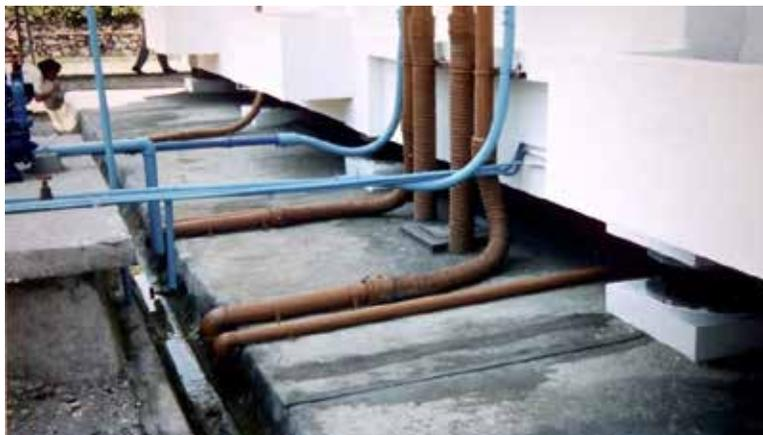
**Figura 3.14:** Tuberías y dispositivos flexibles para permitir los movimientos propios de los edificios con aislamiento sísmico. (Fuente: Kelly, J. 2013).
