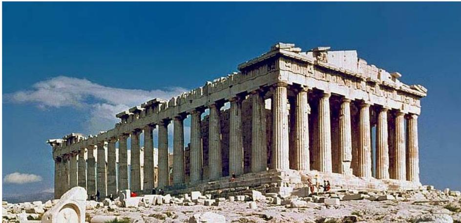
**Figura 1.6:** El Partenón es una estructura fundada en capas de piedras sin mortero, que ha podido soportar los embates de numerosos terremotos.<sup>9</sup>
