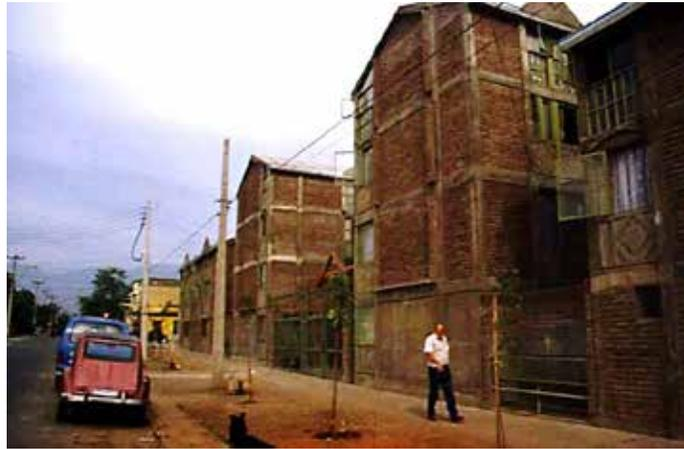
**Figura 8.14:** Comunidad Andalucía. Edificio de mampostería aislado sísmicamente en Chile. (Fuente: Boroschek, R., 2012).
