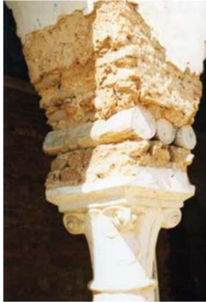
**Figura 1.11:** Aislamiento sísmico compuesto por troncos de madera entre la columna y la arcada. Casbah de Argel.<sup>14</sup>
