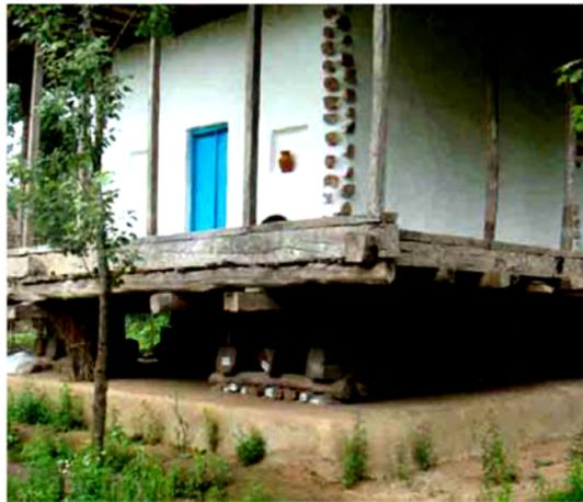
**Figura 1.10:** Fundación de madera que genera aislamiento sísmico. (Fuente: Khoshima, et. al., 2009).<sup>13</sup>
