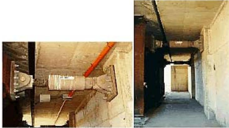
Figura 8.12: Disipadores Taylor en el puente Amolanas.<sup>42</sup>
