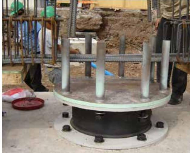
**Figura 3.8:** Aislador sísmico (Fuente: Lara, O, 2015).
