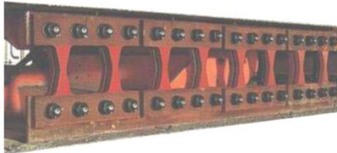
**Figura 7.4:** Disipadores histeréticos metálicos a) Tipo TADAS b) Tipo panel. (Fuente: Oviedo et al., 2006).<sup>32</sup>
