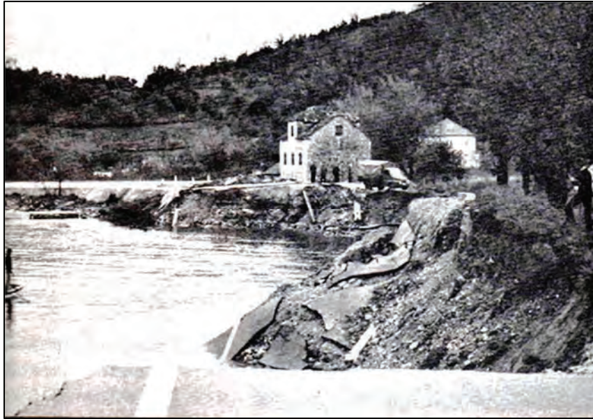
Figura I 15-1: Derrumbe de una parte de la Autopista del Adriático. (Fuente: Leeds, 1980, editor, EERI, 1980, p. 21)
