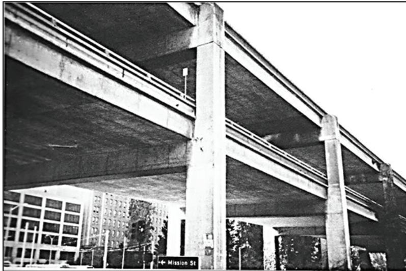
Figura I 24-3: El Cypress Street Viaduct I 880, ubicado en Oakland, antes del sismo (Fuente: Dames & Moore, 1989, p. 13)
