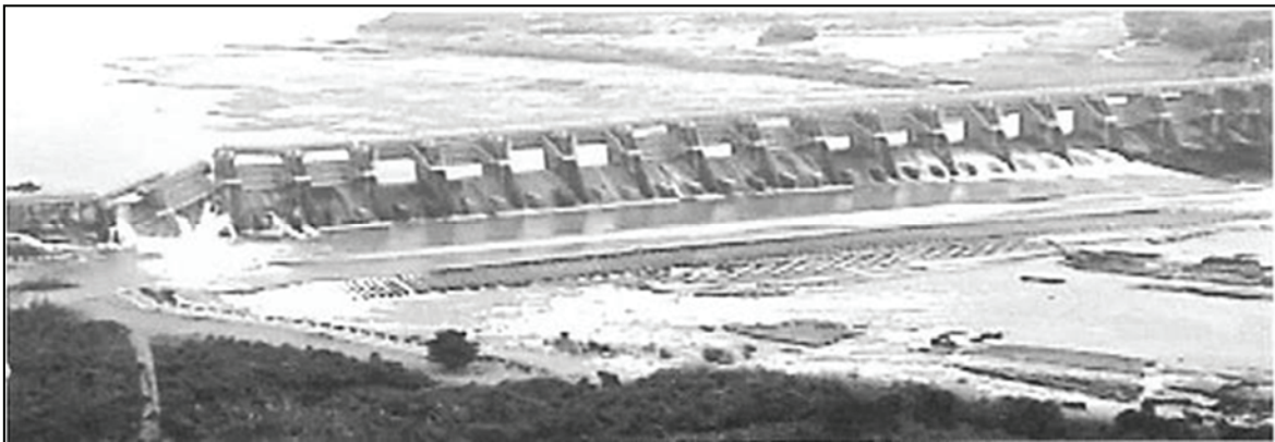
Figura I 32-4: Embalse que sufrió elevación permanente, consecuencia del desplazamiento de la falla de CLPF. (Fuente: BSSA, 2001, p. 995)
