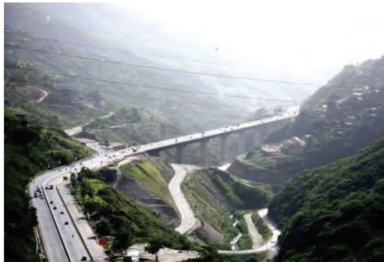
Figura I 40-7: Vista aérea del viaducto culminado ( https://venezuelaoctavaisla.files.wordpress.com/2013/11/nuevo-viaducto-ccslaguaira_04.jpg )
