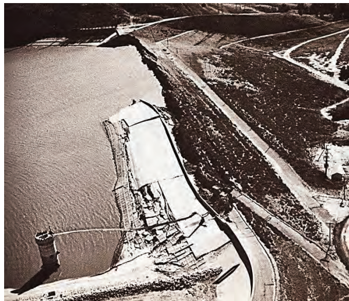
Figura III 3-2: Embalse Lower Van Norman luego del sismo de San Fernando de 1971, ya vaciada una cantidad considerable de agua. Investigaciones posteriores revelaron que las roturas de la cubierta de concreto que se observan, fueron consecuencia de licuefacción del relleno hidráulico. (Foto de R. E. Wallace, USGS Prof. Paper 733, 1974)
