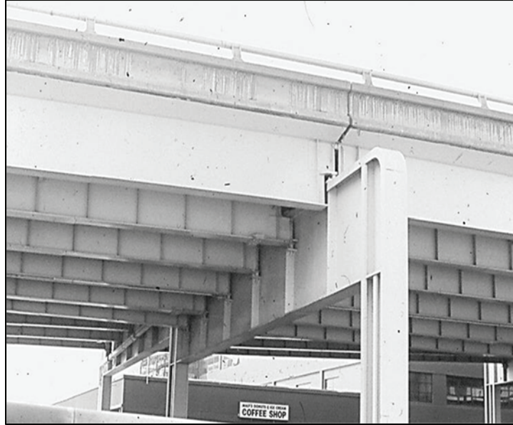
Figura I 24-12: Puente metálico en una de las avenidas de San Francisco. Obsérvese la limitada longitud de los apoyos de los tableros. (Fuente: propia)
