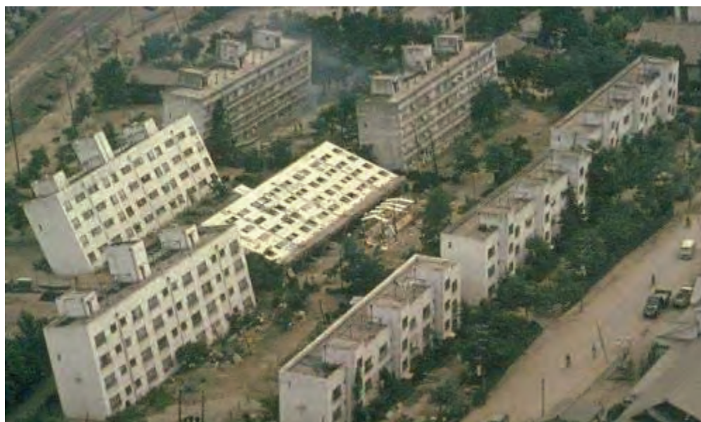
Figura I 7-1: Rotación de fundaciones en edificaciones de varios niveles, área urbana de Niigata (Fuente: Public Domain, https://commons.wikimedia.org/w/index.php?curid=18730337 )
