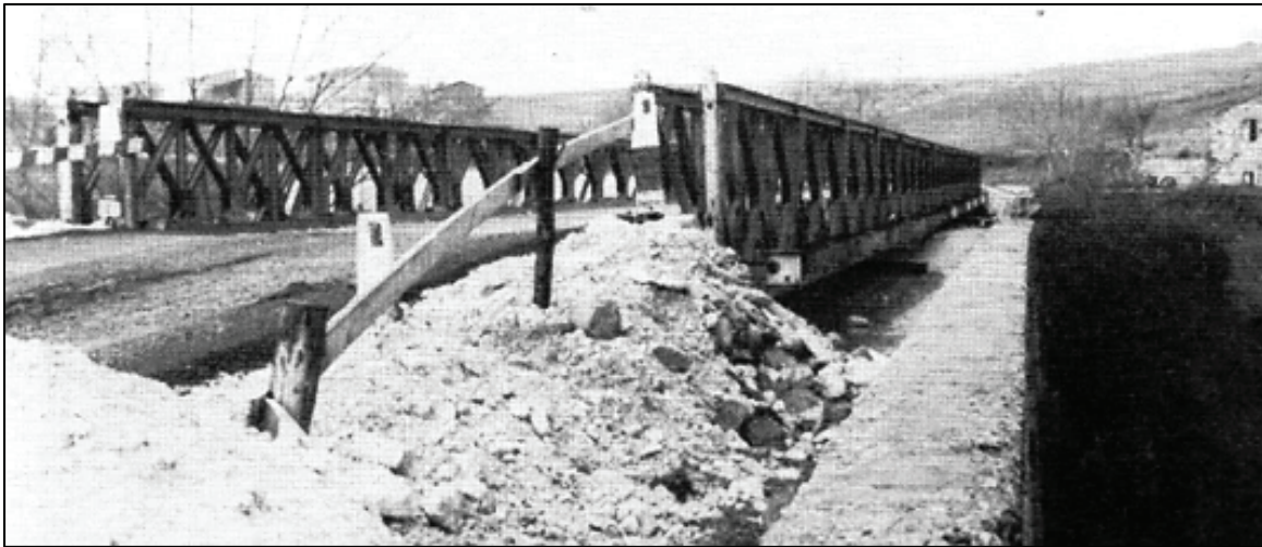
Figura I 18-4: Disposición de un Puente de Guerra para asegurar la entrada a Sant'Angelo dei Lombardi; detalle de la Figura I 18-3. (Fuente: Strata et al., 1981, p. 34)
