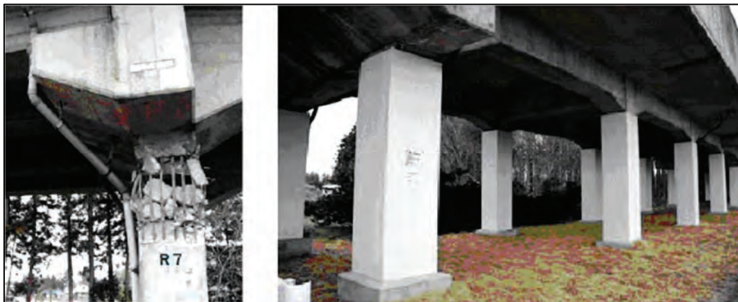
Figura I 36-3: Columnas que soportan vías férreas del tren de alta velocidad Shinkansen en el área de Tohoku. Izquierda: columna aún no reforzada. Derecha: columnas reforzadas. (Fuente: Dr. Takahashi, Kyoto University)
