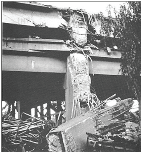
Figura I 24-7: Otra unión similar a la que se ilustra en la Figura I 24-6 (Fuente: EERI, 89-03, portada y p. 38)
