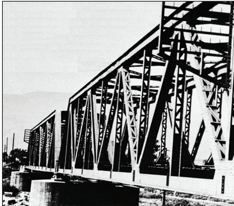
Figura I 5-2: Puente Ferrocarrilero sobre el río Vardar, el cual sufrió desplazamiento de un apoyo en dirección Este. (Fuente: Berg, 1964, p. 39)
