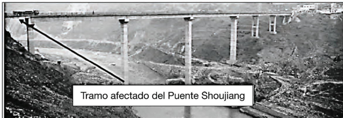
Figura I 34-1: Caída del primer tramo del Puente Shoujiang. (Fuente: Lee, 2008, 19/112)
