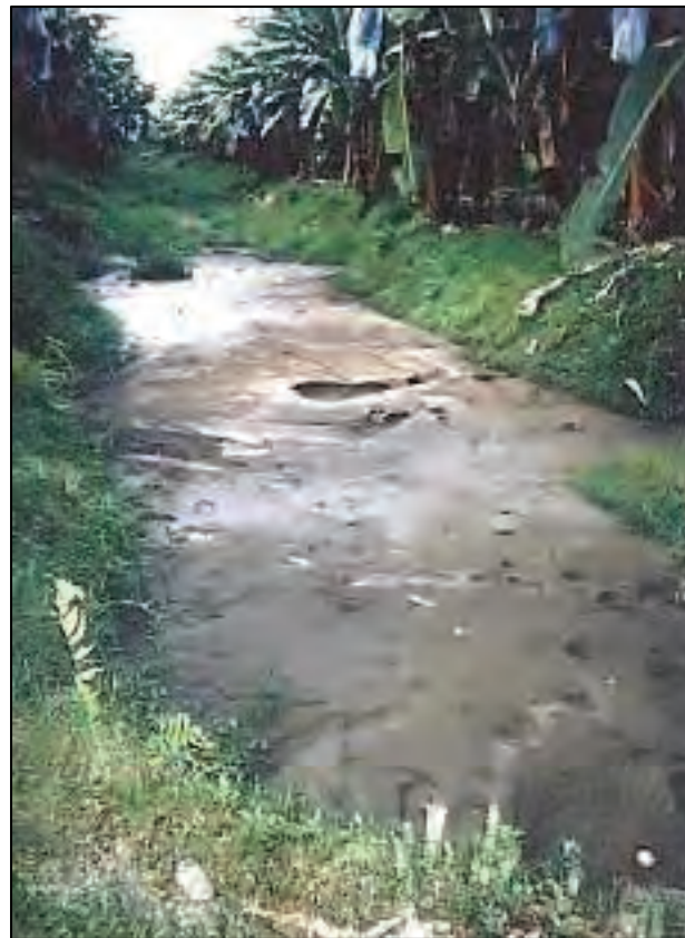
Figura I 26-9: Colmatación con arena fina de canales de drenaje, expulsada del subsuelo por efectos de licuefacción. (Fuente: propia)
