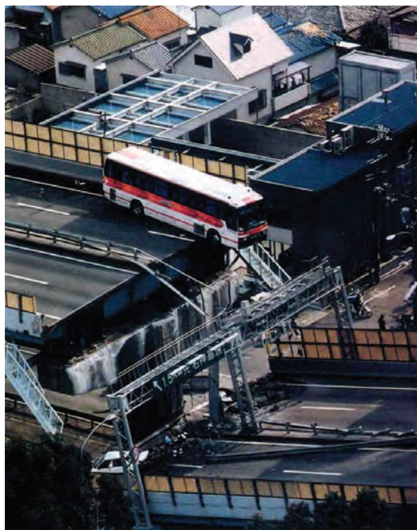
Figura I 30-8: Situación crítica sobre el tablero de la autopista Hanshin ( http://seismic.mgm-monschau.de/english/artikel/artikel_1_3.php )
