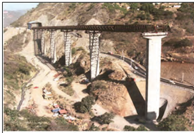
Figura I 40-5: La viga ha alcanzado la pila N°5, deslizándose sobre las cinco primeras. Un detalle de la fundación de estas pilas se da más adelante. (Fuente: Torres et al., 2009, p. 231)
