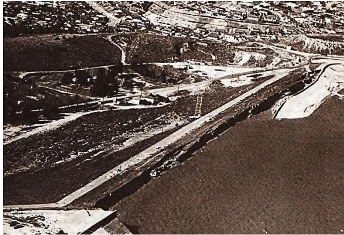
Figura III 3-1: Vista aérea del embalse Lower Van Norman poco después del sismo de San Fernando del año 1971. Más de 80 mil personas habitaban el valle de San Fernando que se aprecia aguas abajo del embalse; éstas recibieron una orden de desalojo inmediatamente después del sismo y se procedió a hacer descender el nivel del embalse. (Foto de Ziony, J. I., USGS, 1971)
