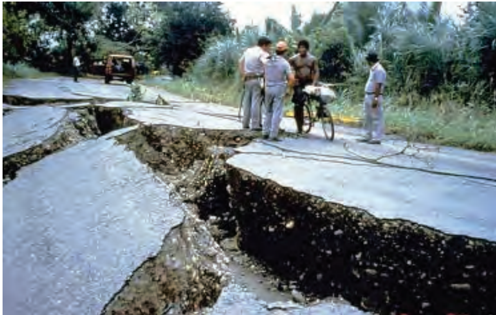
Figura I 26-1: Inestabilidad de una vía de comunicación por desparramamiento lateral (EERI). http://www.eeri.org/
