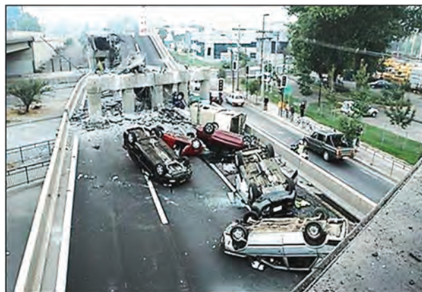
Figura I 35-8: Pérdida de apoyo del tablero (posiblemente de la Autopista Noroeste de Santiago). (Fuente: : EERI/PEER/FHWA, 2010)
