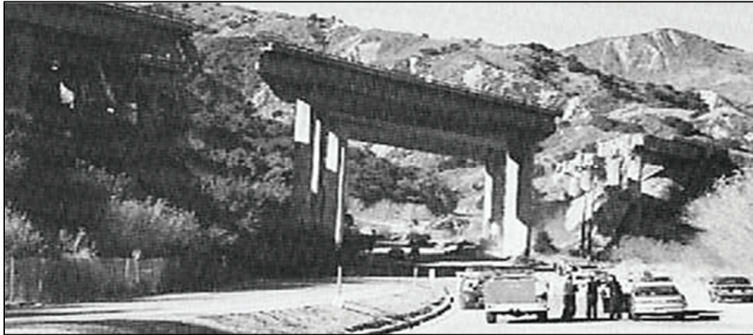
Figura I 29-4: Tramo central de concreto pretensado, en el cruce inferior Gavin-Canyon. (Fuente: Earthquake Spectra , 1995, p. 311)
