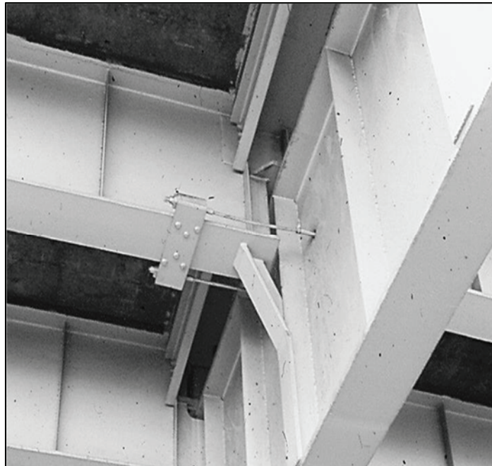
Figura I 24-13: Cara izquierda de uno de los pórticos donde se apoya el tablero. (Fuente: propia)
