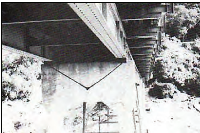
Figura I 19-4: Vista de la parte inferior del puente. En el pórtico se aprecian dos restrictores contra el desplazamiento lateral, dispuestos por Caltrans. (Fuente: Bennett and Sherburne, 1984, p. 89)
