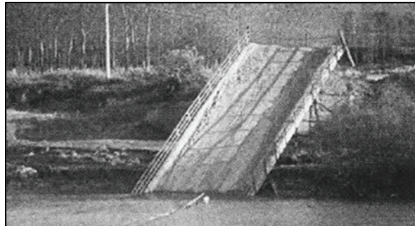
Figura I 31-4: Colapso del Puente sobre el río Sakarya por inestabilidad del terreno de fundación de la pila sumergida. (Fuente: Youd et al., 2000, figure 18.6)
