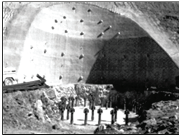
Figura I 40-6: Micropilotes para fundación del nuevo Viaducto Caracas-La Guaira. (Fuente: Torres et al., 2009, p. 237)
