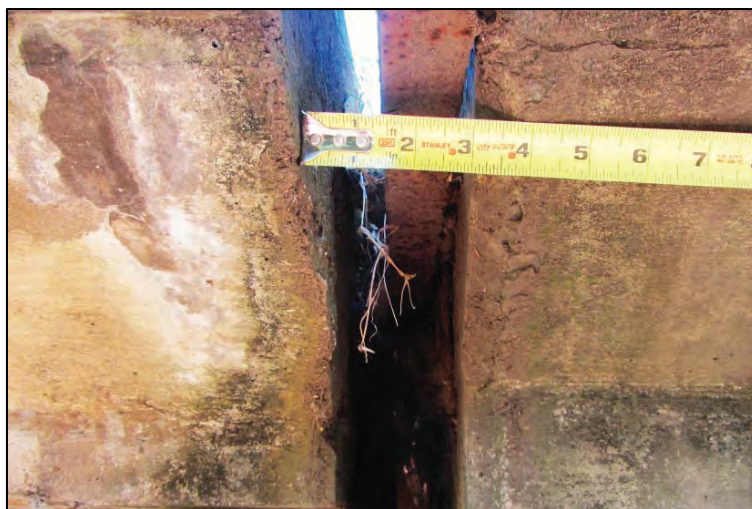
Figura I 38-8: Separación adicional en uno de los extremos del puente. (Fuente: Rollings et al., 2003)
