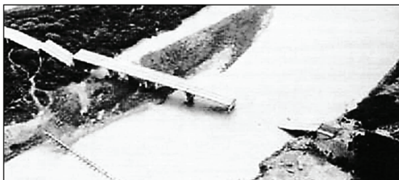
Figura I 20-1: Vista aérea del puente Lo Gallardo sobre el Río Maipo. El tramo colapsado a la derecha, probablemente fue debido a pérdida de capacidad portante por licuefacción del terreno. (Fuente: Wyllie et al. 1986)
