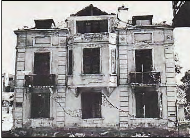
Figura I 5-1: Edificación de mampostería que muestra la acción de un fuerte pulso hacia el Oeste (izquierda en la Figura) de su ubicación. (Fuente: Berg, 1964, p. 47)
