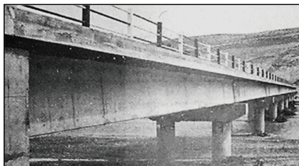
Figura I 10-1: Vista del puente Shah-abad de 330 m de largo. (Fuente: Moinfar, 1972, p. 7)
