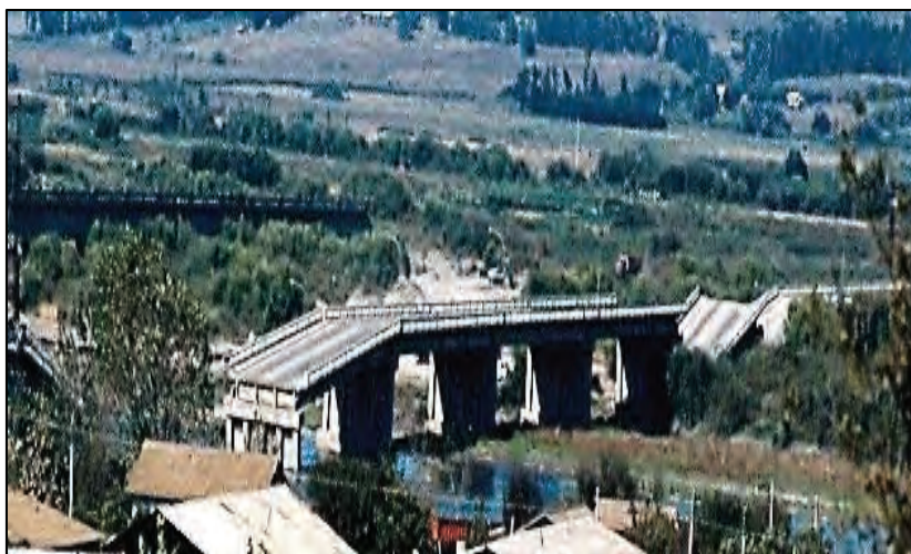
Figura I 20-5: Vista aérea de los efectos en la Pila 2 y en tramos anteriores al extremo de la citada pila. (Fuente: propia)
