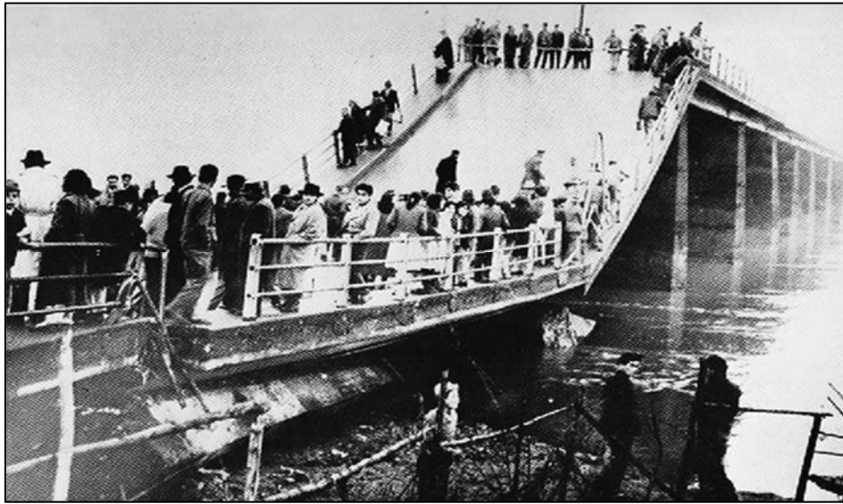
Figura I 4-2: Desplome de pilas cercanas al acceso del puente sobre el río Bio Bio cerca de Concepción. (Fuente: Andrews, 1963, p. 97)
