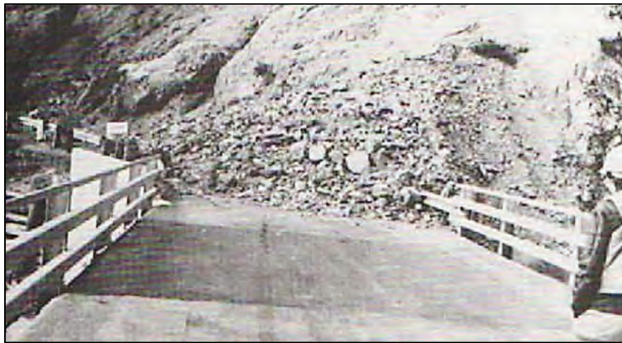
Figura I 19-3: Bloqueo del puente East Dunne Avenue por deslizamiento de rocas. (Fuente: Bennett and Sherburne, 1984, p. 88)
