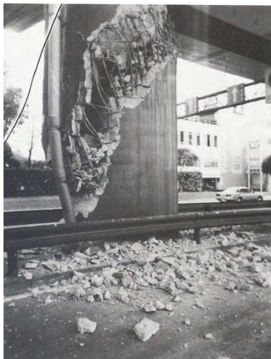
Figura I 30-12: Por su enorme rigidez, esta columna no resistió el corte asociado. (Fuente: EERI, 1995, p. 49)
