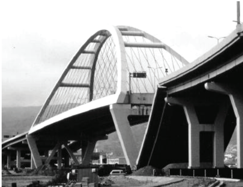
Figura I 30-19: En la parte central de la Figura destaca el tramo caído, acceso al puente Nishinomiya-ko, hacia la Isla Rokko. (Fuente: Brando, M., 2010-2011)
