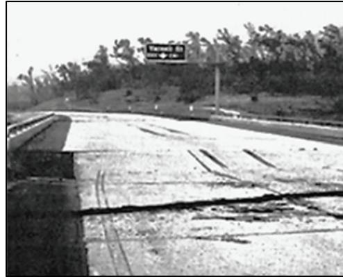
Figura I 9-3: Ruta 210 en la calle Roxford. Extremo izquierdo. Obsérvese que el asentamiento en la zona central, puso a volar un automóvil. (Ref: NOAA, 1973, vol II, p. 203)
