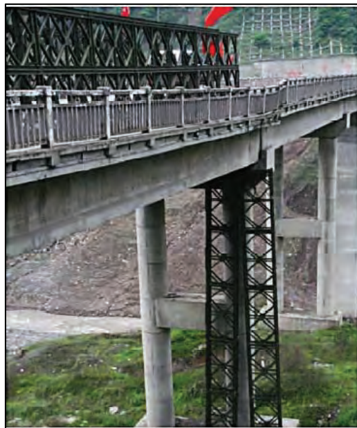
Figura I 34-2: Reparación temporal del primer tramo del Puente Shoujiang . (Fuente: Lee, 2008, 20/112)
