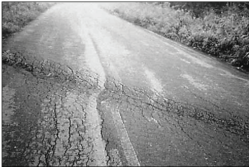
Figura I 26-3: Desplazamiento transcurrente dextral, de falla secundaria en el área de Fortuna-Chiriqui, Panamá, consecuencia del sismo de Costa Rica de 1991. (Fuente: Camacho, et al., 1991, p. 56. Instituto de Geociencias de Panamá. http://revistas.ucr.ac.cr/index.php/geologica/article/viewFile/13446/12701 )
