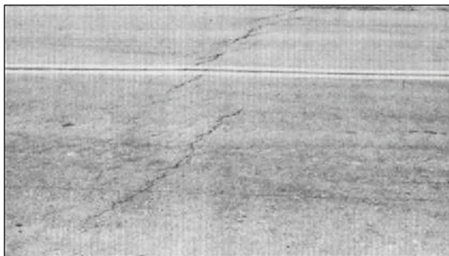
Figura I 19-1: Vista en dirección Sur-este de evidencias superficiales del desplazamiento permanente de la Falla de Calaveras. (Fuente: Bennett and Sherburne, 1984, p. 182)
