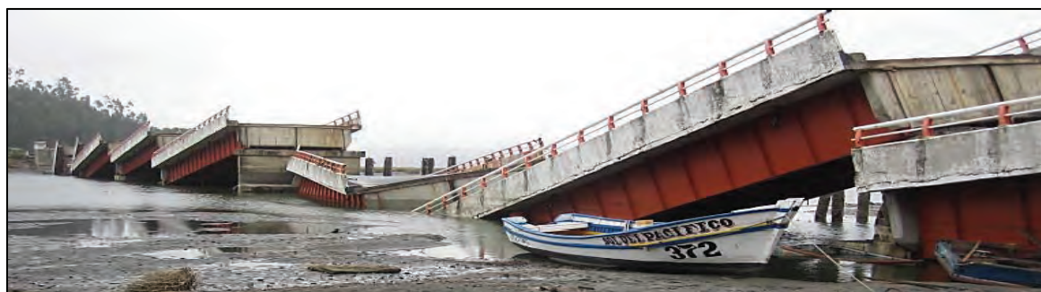
Figura I 35-6: Extremo derecho del Puente Tubul. (Fuente: EERI/PEER/FHWA, 2010)
