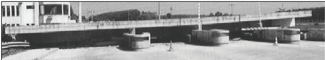
Figura I 31-5: Desplome del techo de una Estación de Peaje. (Fuente: Youd et al., 2000, figure 18.7)
