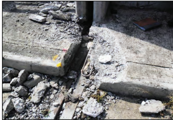
Figura I 38-6: Zona de interacción entre el sector atirantado y el apoyado. (Fuente: Rollins et al., 2013)
