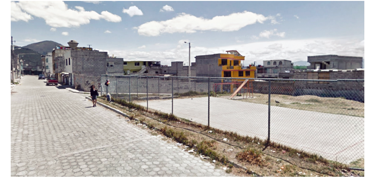
PLAZA TIPO antes de la intervención
