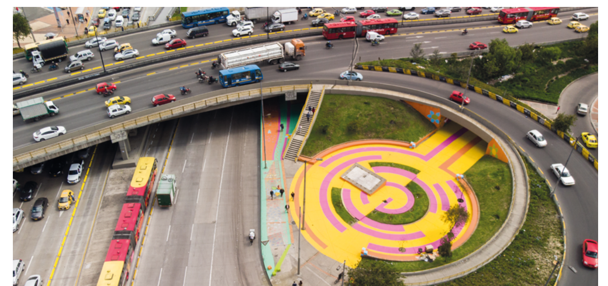
Imágenes 2 – Arriba: perspectiva isométrica de la intervención. Arriba-derecha: antes y después de la intervención en el pasaje soterrado, nótese como la diferencia en la calidad del espacio y la iluminación pueden generar un cambio de percepción de la seguridad en las usuarias y los usuarios. Derecha: Imágenes tomadas durante el proceso de intervención. Debajo: Vista de conjunto del resultado final. Fuente: Bicistema Arquitectura y urbanismo, 2019
