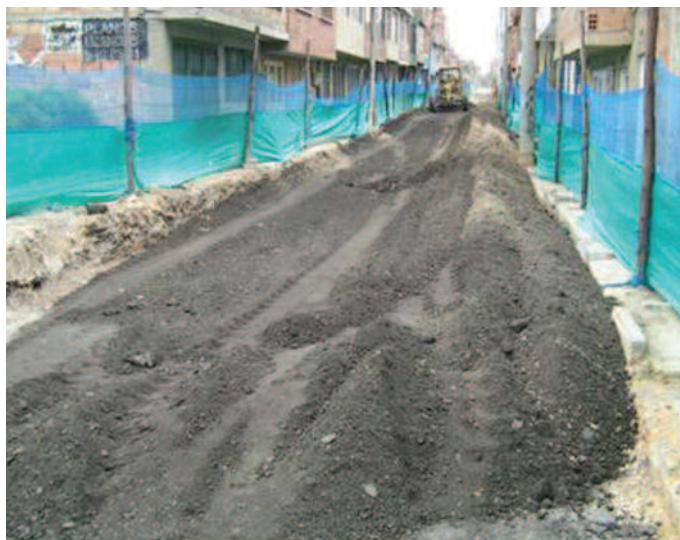
MATERIAL DE RECICLAJE, APLICADO COMO BASE ESTABILIZADA. BOGOTÁ, COLOMBIA
