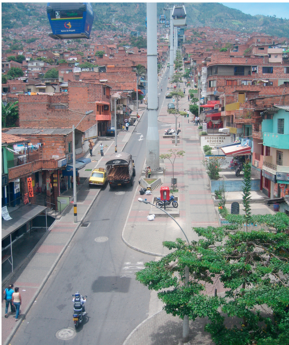
Imagen 3 - La colocación de los postes del Metrocable en la Calle 34 han dado prioridad al peatón
