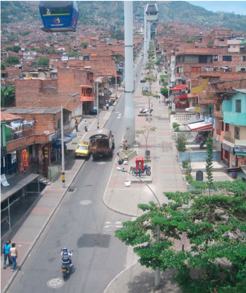
Imagen 3 - La colocación de los postes del Metrocable en la Calle 34 han dado prioridad al peatón
